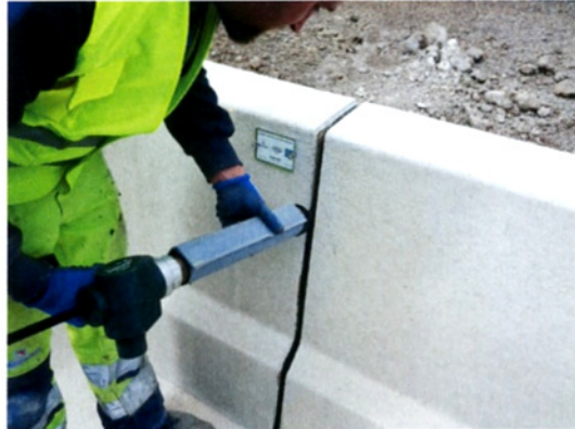
Bild 2: Zum Verfüllen der Fugen mit der Schutzmasse TOK®-BSW Protect auf der Fugenmasse TOK®-BSW Mastic verwendete das Team von Schnorpfeil eine spezielle, akku-betriebene Austragskartusche (Foto: Denso)
