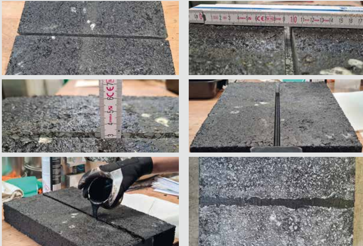
Bild 14: Herstellung einer Asphalt-Probeplatte mit Längsfuge und Bitumenheißver-gussmasse
