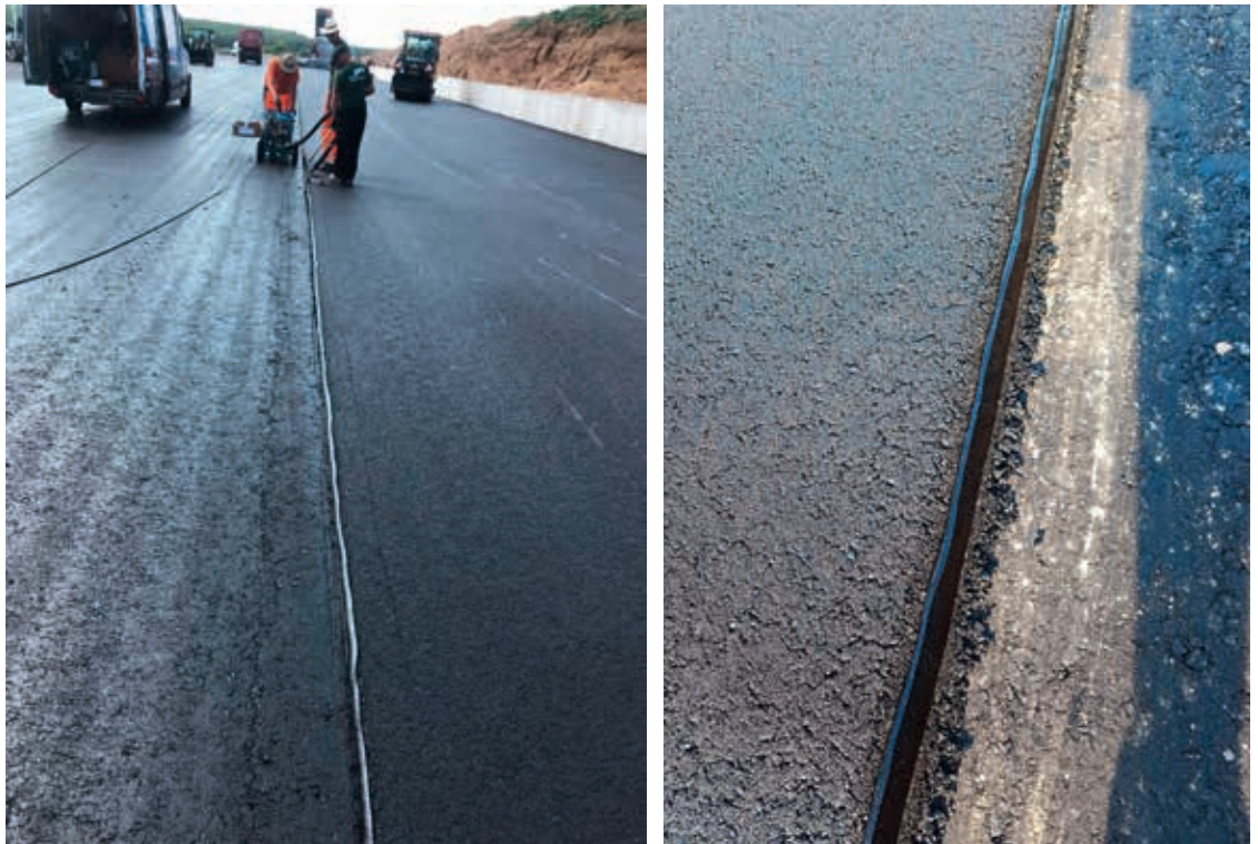
Abbildung 6: Nahtausbildung in einer Asphaltfläche einer JGS-Lagerfläche (Quelle: Denso)
