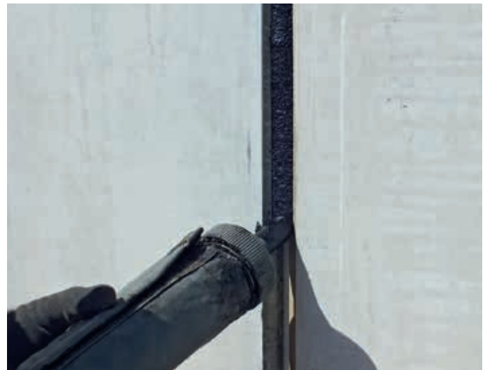
Abbildung 4: Vertikal eingebaute Fugenmasse
