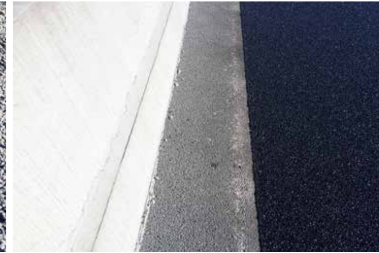
Alter und neuer OPA-Belag im direkten Vergleich (Quelle: Denso)
