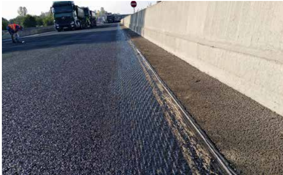
TOK-Band SK Drain auf der A67
