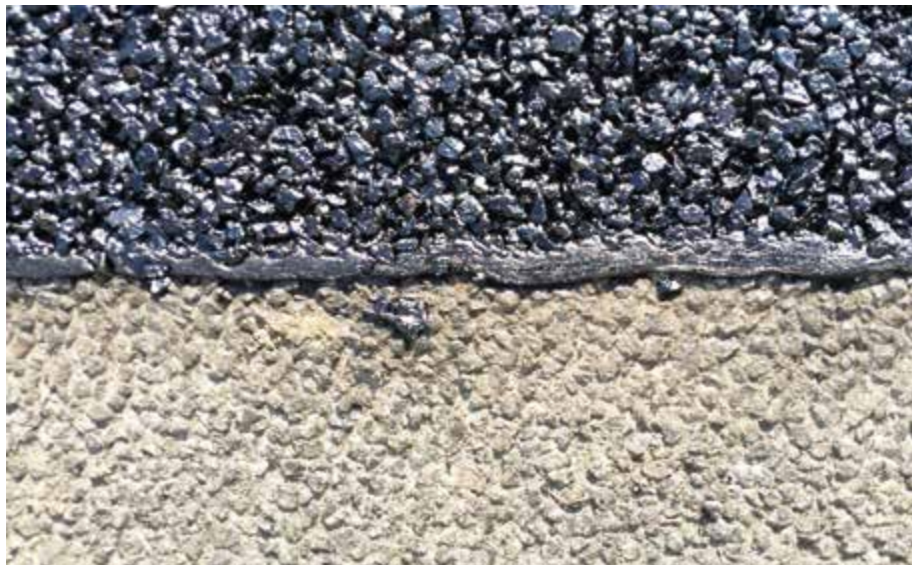
Mit TOK-Band SK Drain ausgebildete Fuge in Offenporigem Asphalt
