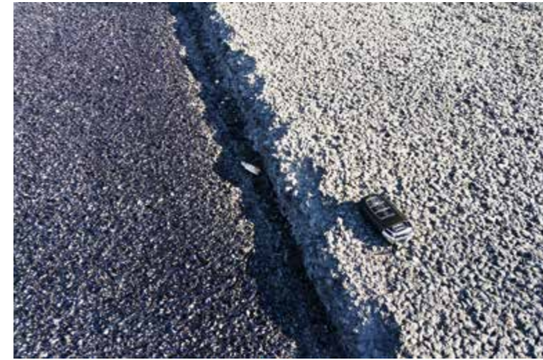
Die Arbeiten auf der A67 begannen im Sommer 2016 mit dem Abfräsen der Asphaltdeck- und -binderschicht.
