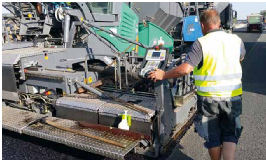
Der Asphalt konnte am Fugenband problemlos eingebaut werden – es gab keinerlei Probleme an der Bohle des Asphaltstraßenfertigers.
