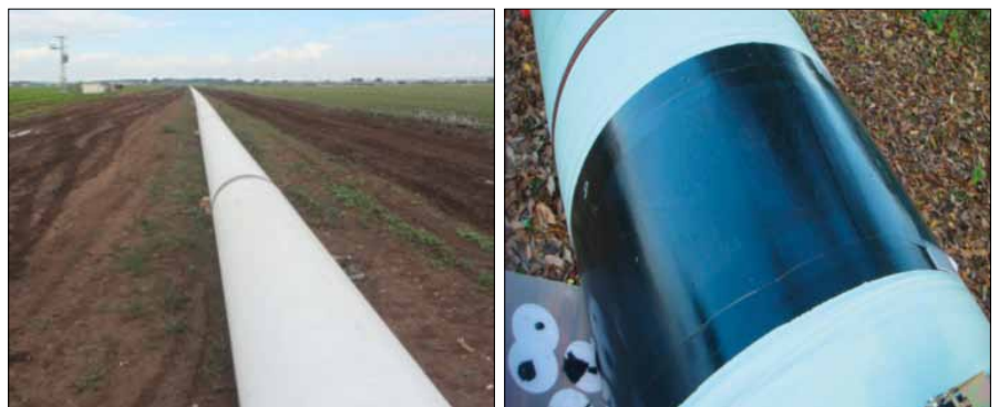
Abbildung 4 : Verlegung in Israel
