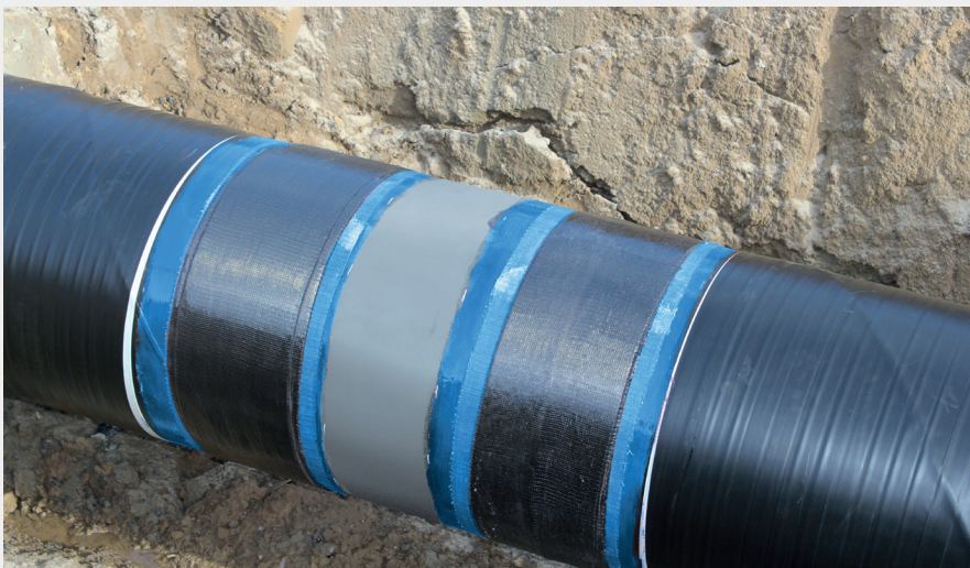
Bild 1: Pipeline-Reparatur mit DEXPAND®-CF70
