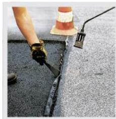
**TOK®-Sil Resist:** standfestes Fugendichtmittel für Biogasanlagen
