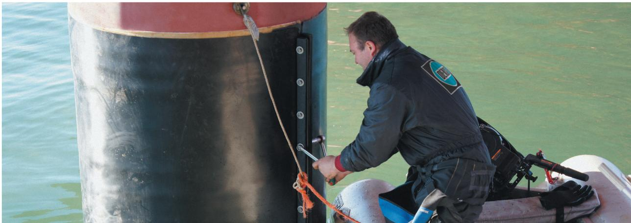
**С. М.:** При этом важно подчеркнуть ремонтнопригодность MarineProtect™. При необходимости возможен контроль состояния конструкции, частичный демонтаж и обратный монтаж системы. Ремонт осуществляется водолазами без применения специального оборудования.
