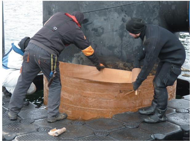
успешно пройдены демонстрационные испытания материала DENSOLD®-HDD — высокопрочного антикоррозионного покрытия для защиты сварных стыков при ГНБ. Организаторами данных испытаний являлись ООО «Стройгазмонтаж» и ООО «Подводтрубопроводстрой» (ПТПС).
