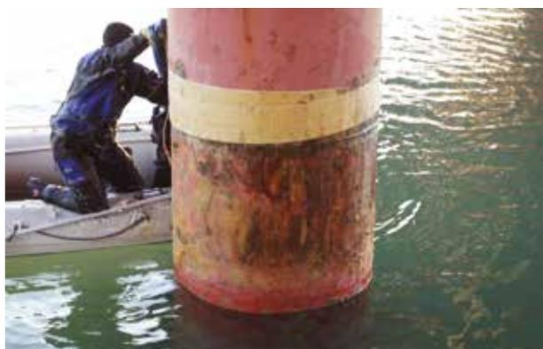
**Нанесение ленты на надводную часть сваи**
