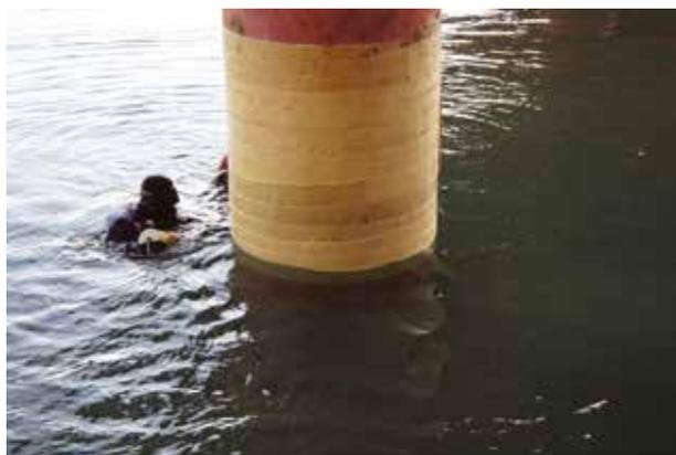
**Нанесение ленты на подводную часть сваи**
