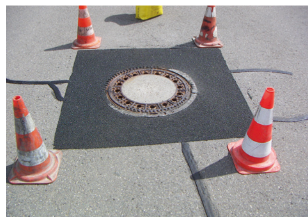
Abb. 2: Ausgleich des Überstandes einer Schachtdeckung und Beschichtung der Oberfläche neben dem Schacht. Fotos: DENSO GmbH
