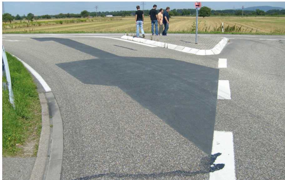
Abb. 1: Mit dem TOK-DUR sanierter grossflächiger Bereich einer Asphaltstrasse.
