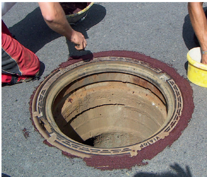
Abbildung 10: Abschließende Feinarbeit an der Oberfläche nach dem Einbau
