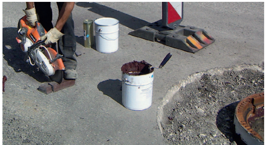
Abbildung 5: Zuschnitt Abstandhalter aus Restmaterial
