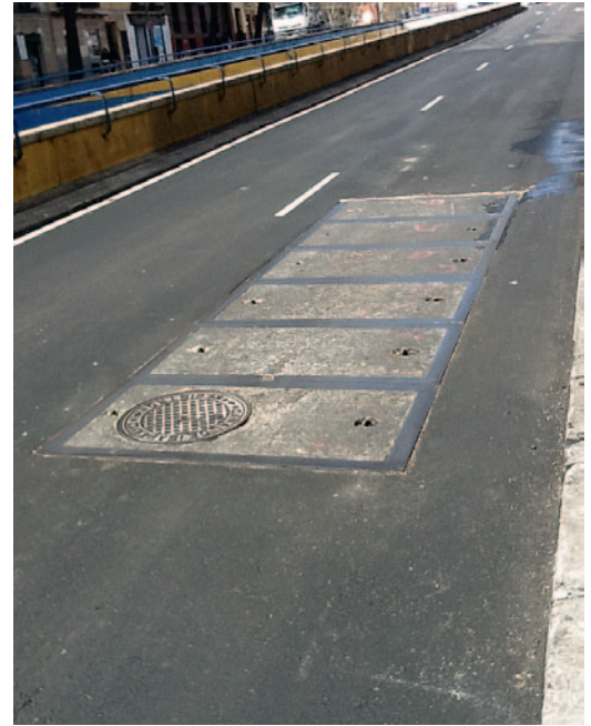
Abbildung 11: Problemschacht in Madrid nach dem Einbau des Mörtels
