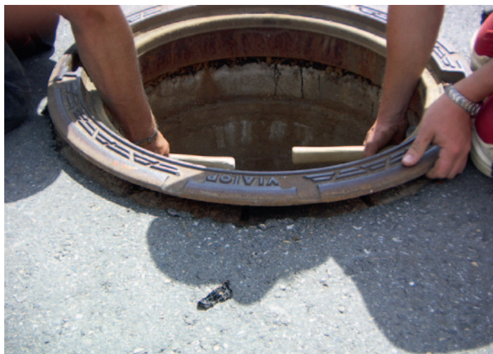
Abbildung 7: Die eingewalzte Abdeckung wird heraus gezogen
