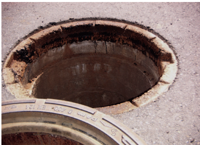
Abbildung 8: Situation nach Ausbau der Abdeckung
