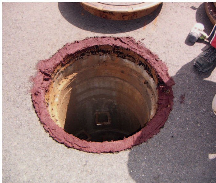
Abbildung 9: Aufmörtelung mit Densolastic EM
