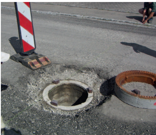
Abbildung 6: Abstandhalter auf der Unterlage aufgelegt
