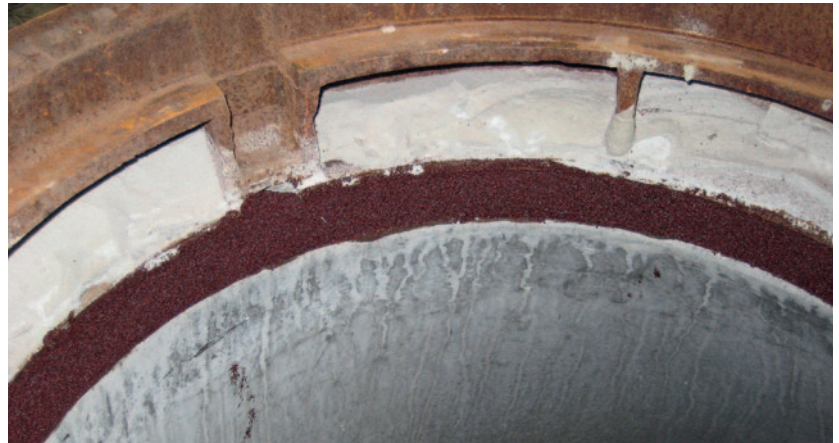
Abbildung 4: Mörtelfuge mit Densolastic EM
