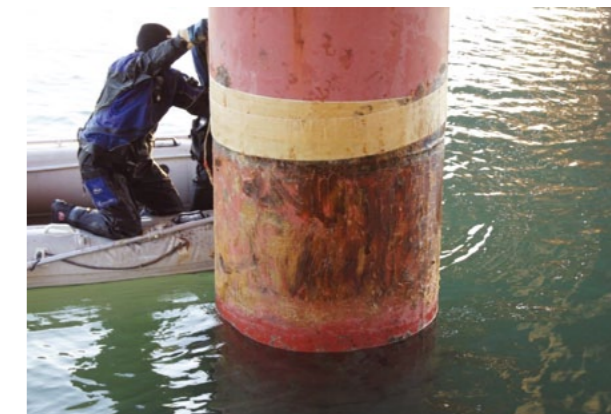
Рис. 8. Нанесение ленты на надводную часть сваи
