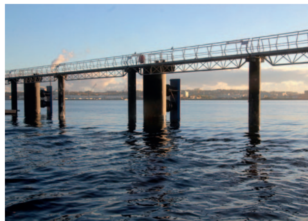
Германия, порт Киль, Балтийское море MarineProtect®-2000 FD Защита свай на крупнейшей пристани круизных лайнеров, DN 2400 (96")
