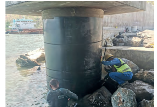
Timor Oriental, terminal de contenedores de Tibar MarineProtect®-100 30 pilotes, DN 1800 (72")
