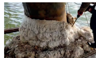
Depósitos agresivos de sal
