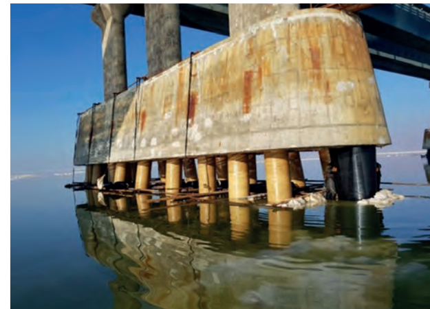
Irán, puentes en el Lago Urmía MarineProtect®-100 372 pilotes, DN 800 (32")
