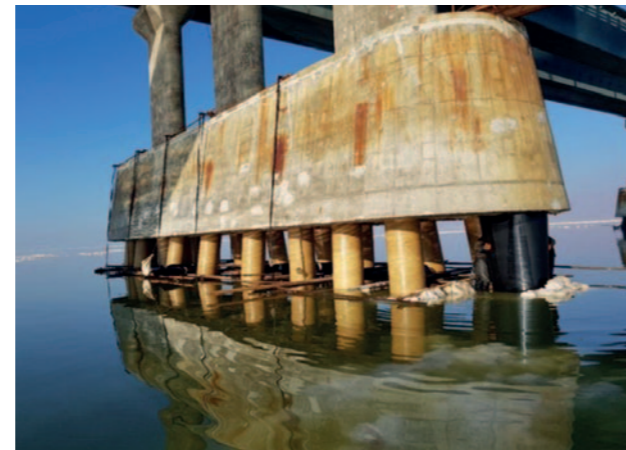
Iran, Brücke im Urmia See MarineProtect®-100 372 Pfeiler, DN 800 (32")
