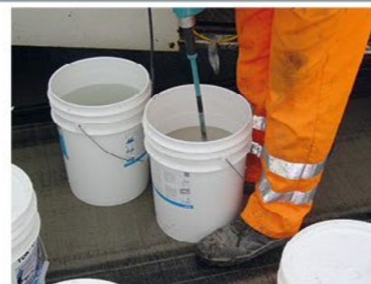
Смешивание Смешать TOK®-Crete 45 с водой (20 кг на 1,2 л воды).
