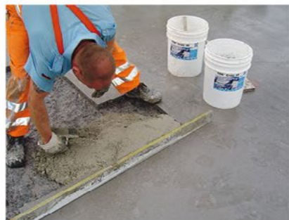
Установка Наносить оперативно, так как время возможной обработки составляет 10 минут.
