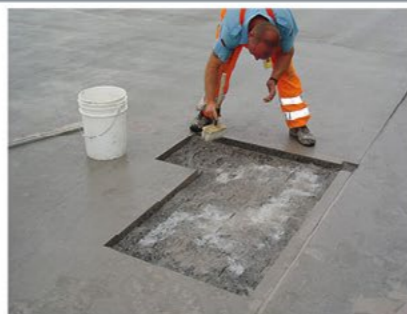
Подготовка Смочить подготовленную поверхность. Адгезионная грунтовка не требуется.
