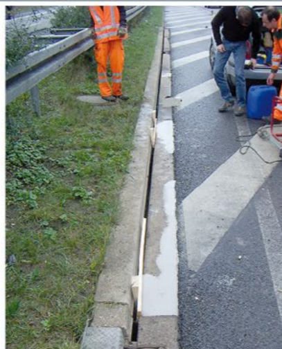
Опалубка и нанесение Установить опалубку, смешать и нанести материал. Немного подождать. Снять опалубку.
