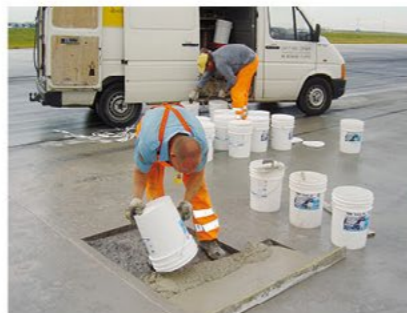
Установка При больших объемах ремонта рекомендуется работать вдвоем для непрерывного нанесения «свежим по свежему».
