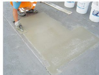
Выравнивание Выравнивать или затирать раствор сразу же. Уже через 8 часов достигается сопротивление сжатию ок. 30 Н/мм 2 .
