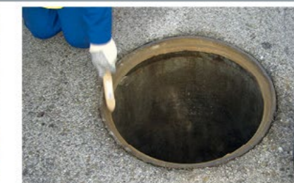
Retirer la rouille Supprimer ensuite le dépôt de rouille sur le support à l'aide d'une brosse métallique, puis essuyer la surface à sec.
