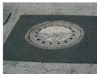
Couche d'égalisation terminée Ensuite, enlever le matériau de sablage au balai. La route peut être ouverte à la circulation.
