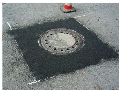
Sabler Sabler ensuite la surface (p. ex. avec du quartz coloré ou des laitiers de haut fourneau), afin de garantir une bonne adhérence de la surface. La couleur du sablage détermine la couleur du ragréage terminé.
