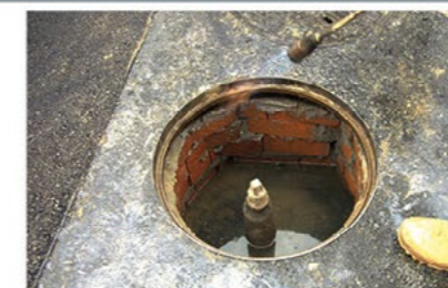
Sécher Sécher cette zone au chalumeau.
