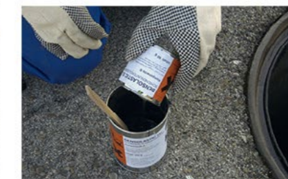
Mélanger Commencer par bien mélanger le composant A, puis incorporer le composant B.
