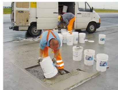
Application Lorsque les travaux sont importants, il est recommandé de faire travailler 2 personnes, afin que le mélange puisse toujours être appliqué « frais sur frais ».
