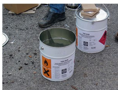
Ragréage sur enrobé Ragréage sur enrobé et composants du durcisseur
