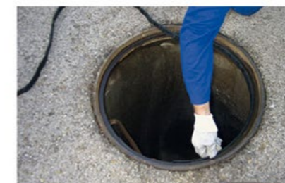
Placer le coffrage Appliquer sur le bord intérieur du logement du couvercle la bande TOK®-Band SK , TOK®-SK Rissband ou scotch américain en la laissant dépasser d'environ 3-4 mm.
