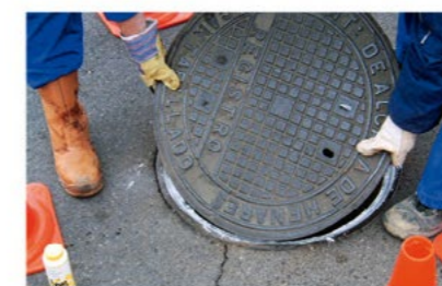
Replacer la plaque Remettre ensuite la plaque d'égout en place. Il est important ici de respecter un bon timing entre l'application du produit et le remplacement de la plaque afin d'obtenir l'effet escompté.
