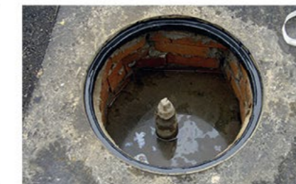
Laisser sécher En fonction des conditions météorologiques et de la température, attendre environ 10-20 minutes jusqu'à ce que le produit soit sec, mais pas encore durci (à tester au doigt !).
