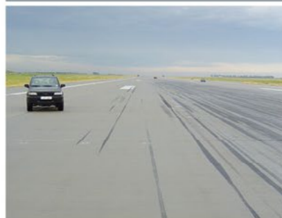
Surface en béton d'un terrain d'aviation Piste de décollage et d'atterrissage à l'aéroport de Leipzig.
