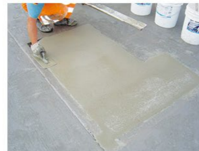
Lisser Le lissage et le nivellement doivent se faire immédiatement. Après 8 heures, le matériau présente une résistance à la pression de 30 N/mm 2 environ.
