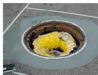
Appliquer Appliquer ensuite le produit mélangé. Une deuxième application est possible.
