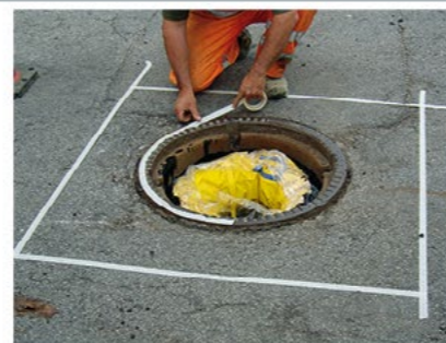
Protection de l'anneau du regard Il faut également protéger le cadre du regard (avec un scotch par exemple).
