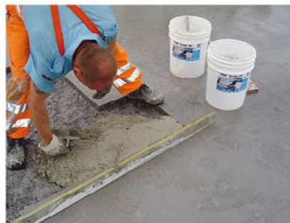
Application Appliquer immédiatement après le mélange, car la durée de vie en pot est de 10 minutes.
