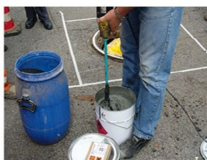
Mélanger Mélanger le ragréage sur enrobé. Ajouter ensuite le durcisseur et bien mélanger. Le cas échéant, ajouter du sable de quartz pour corriger les inégalités importantes.
