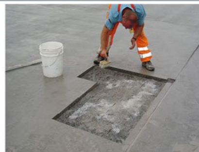
Préparation Mouiller les surfaces préparées. Un primaire d'accrochage n'est pas nécessaire.
