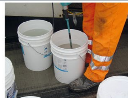
Mélanger Mélanger le TOK®-Crete 45 avec de l'eau (20 kg = 1,2 litre d'eau).
