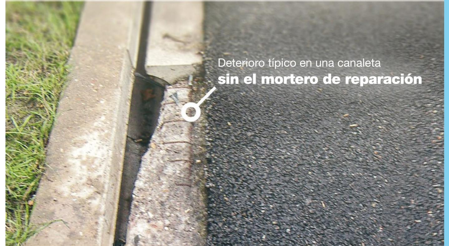
Deterioro típico en una canaleta sin el mortero de reparación
