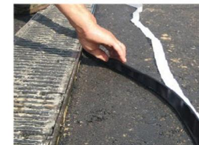
Perfil TOK®-Band SK en desagües y superficie de asfalto.
