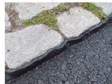
Elaboración de juntas en canales de piedras de bordillo con el perfil TOK®-Band SK o con el procedimiento TOKOMAT®.
