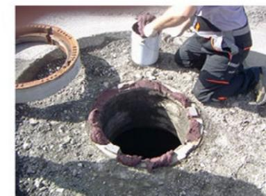
La temperatura exterior y la temperatura de los componentes tienen que ser de más de +5 °C (+41 °F). El contenido del componente B se deberá añadir por completo al envase del componente A y remover los dos componentes a fondo con un agitador eléctrico a una velocidad de como mín. 500 rpm entre sí. En envases pequeños se removerá por lo menos
