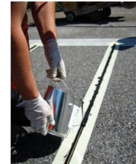
La temperatura de la superficie de la junta tiene que ser de por lo menos +5 °C (+41 °F), máx. +40 °C (+104 °F). Hay que tener en cuenta en todo caso el punto de condensación. Si ascendieran burbujas de aire, se deberán eliminar (p. ej. pasando un pincel o aplicando brevemente la llama de un quemador a gas) antes de que el material se haga sólido. Los perfiles adhesivos puestos antes de aplicar la imprimación (por motivos estéticos) se deberán quitar directamente después del vertido.
