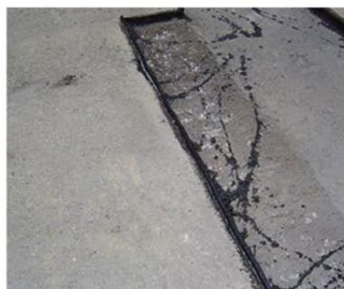
**Saliente** - El perfil para el sellado de juntas debe sobresalir 5 mm. En caso de firme de asfalto colado no es necesario que el perfil sobresalga porque luego no se apisona con un rodillo.
