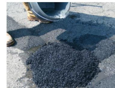
La superficie puede ser transitable inmediatamente después de su aplicación. En caso de carga extrema, la superficie debería liberarse pasada aprox. una hora. A temperaturas alrededor del punto de congelación deberá contarse con tiempos de endurecimiento prolongados.
