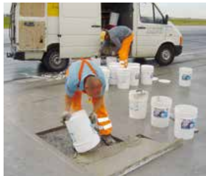
Einbau Es wird empfohlen bei größeren Maß- nahmen mit 2 Personen zu arbeiten, damit stets „frisch in frisch“ eingebaut werden kann.
