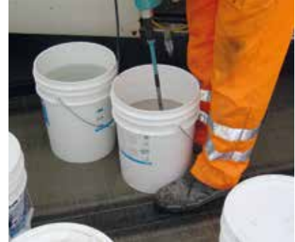
Mischen TOK®-Crete 45 mit Wasser anmischen (20 kg = 1,2 Liter Wasser).
