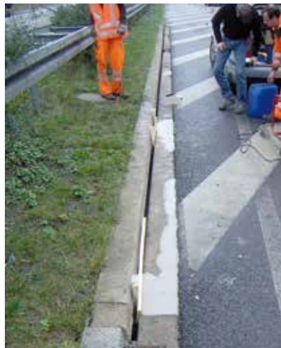
Einschalen und Einbauen Einschalen, Material anmischen, einbauen. Kurz warten. Ausschalen.
