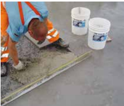
Einbau Anschließend zügig einbauen, da die Topfzeit 10 Minuten beträgt.
