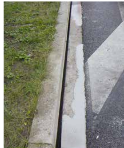
Fertige Reparatur Einpacken. Fertig.
