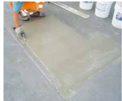
Glätten Das Glätten oder Abziehen muss unmittelbar erfolgen. Nach 8 Stunden ist bereits eine Druck- festigkeit von annähernd 30 N/mm 2 erreicht.
