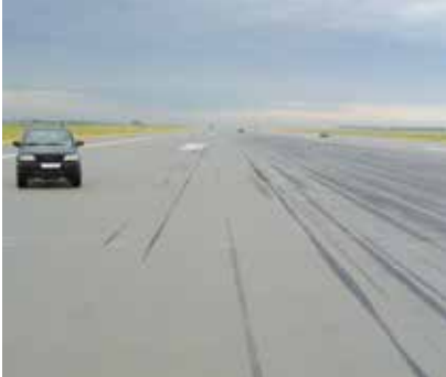
Flugfeld Betonoberfläche Start- und Landebahn am Flughafen Leipzig.
