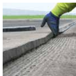
Appliquer le TOK ® -Band SK par pression
