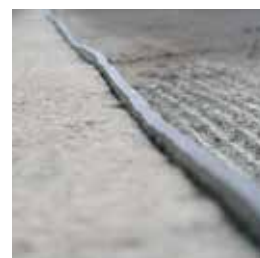
De colocación sencilla, con un resalte de 5 mm en caso de asfalto compactado
