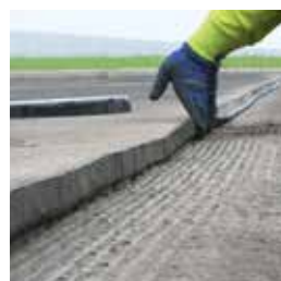
Fijar y apretar el perfil TOK ® -Band A
