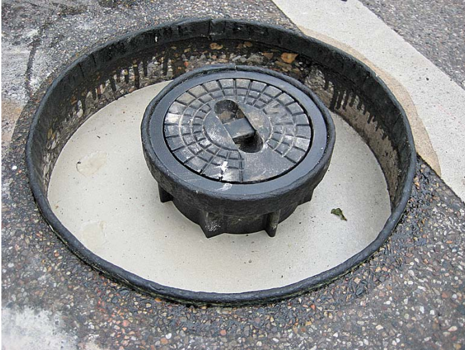
Abbildung 2: Einbau eines Bitumenfugenbandes an einer Schieberkappe
