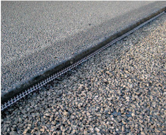
Abbildung 4: Das Ergebnis ist ein sauber verlegtes Bitumenfugenband an einem offenenporigen Asphalt
