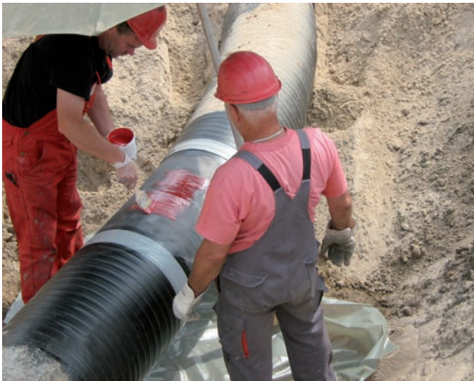
Fig. 2: Application of Epoxy primer
