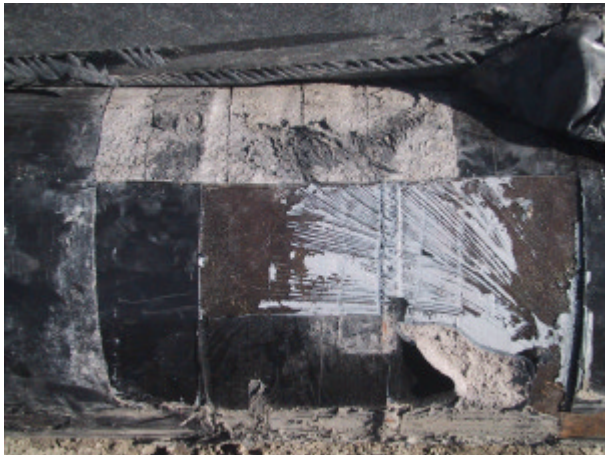
Bild 5: Partiiell freigelegte Schweißnaht DN300 mit DENSOLEN-System S40.
