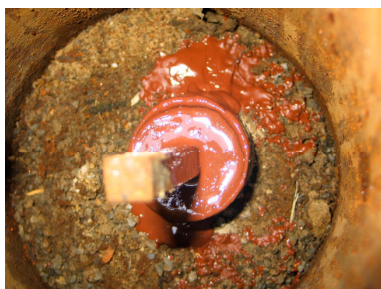
d) Vollständig mit DENSO KS-Masse verfülltes Hülsrohr
