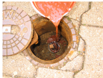
c) Verfüllung des Hülsrohres
