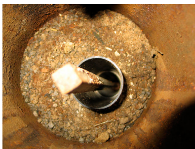
a) Hülsrohr vor der Verfüllung
