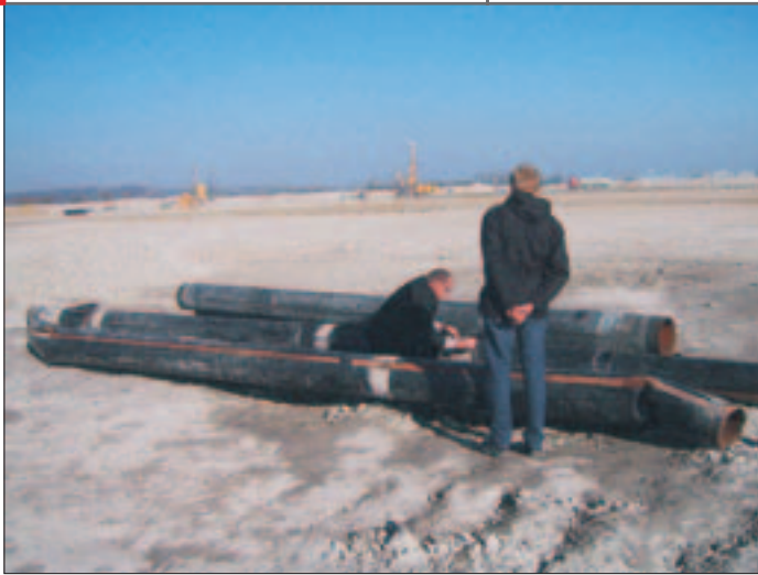
Bild 2: Ausgebaute Rohrabschnitte DN 300
