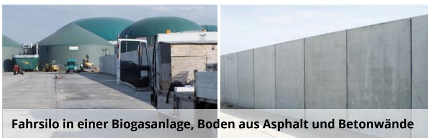
Fahrsilo in einer Biogasanlage, Boden aus Asphalt und Betonwände
