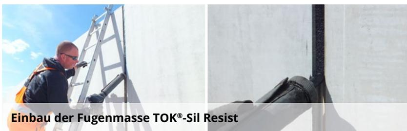
Einbau der Fugenmasse TOK®-Sil Resist
