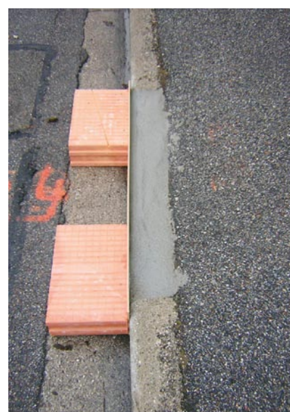
Einsatz von TOK-Crete 45 v2.0 im kommunalen Bereich an Bordsteinkanten
