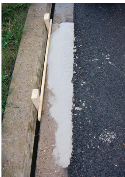
Reparaturmörtel TOK-Crete 45 v2.0 – die Materialeigenschaften bringen deutliche Vorteile für die Sanierung von Schlitzrinnen aus Beton
