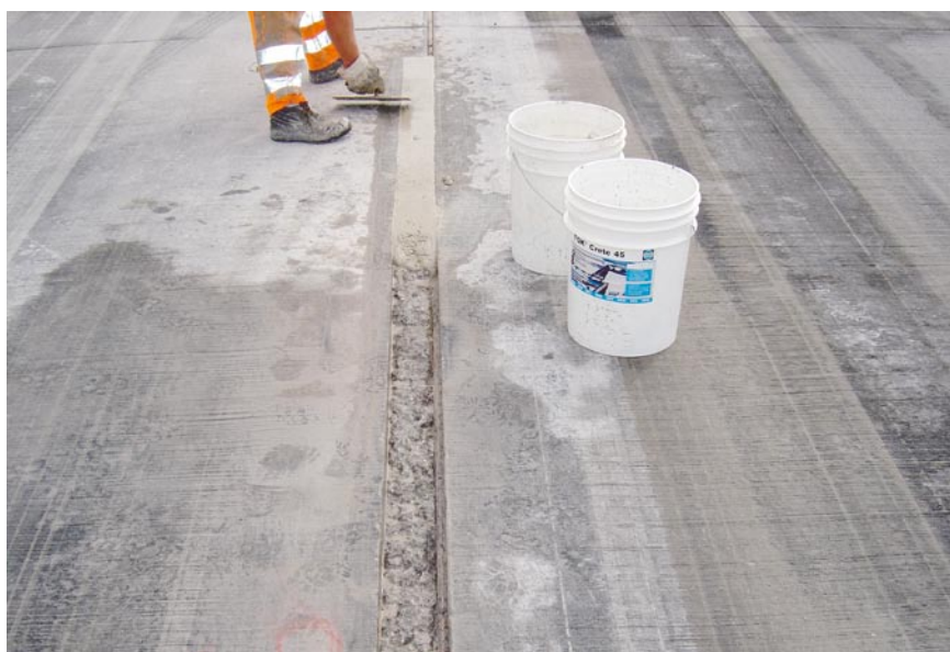
Sanierung einer Flugverkehrsfläche
