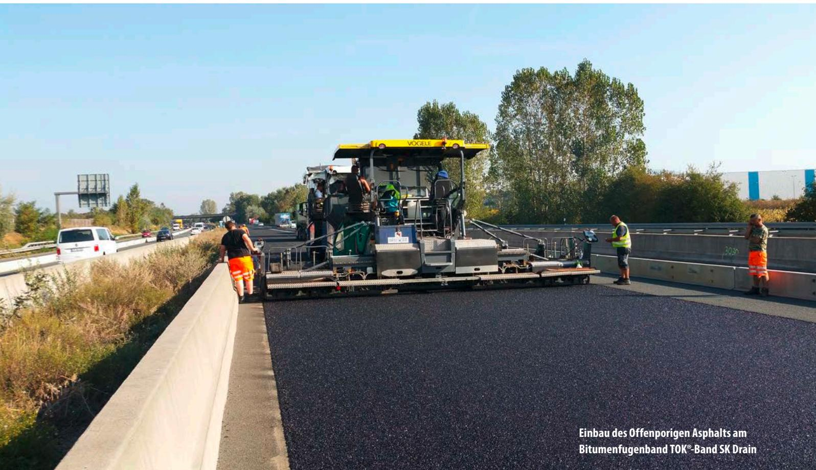
Einbau des Offenporigen Asphalts am Bitumenfugenband TOK®-Band SK Drain
