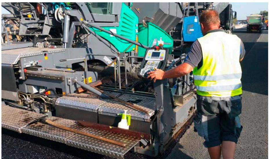
Der Asphalt konnte am Fugenband problemlos eingebaut werden – es gab keinerlei Probleme an der Bohle des Asphaltstraßenfertigers.
