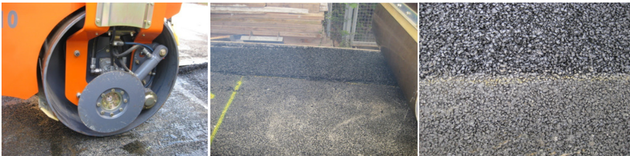
Bild 2: Nahtherstellung durch eine Kantenandrückrolle an der Walze in der Versuchsreihe 2
