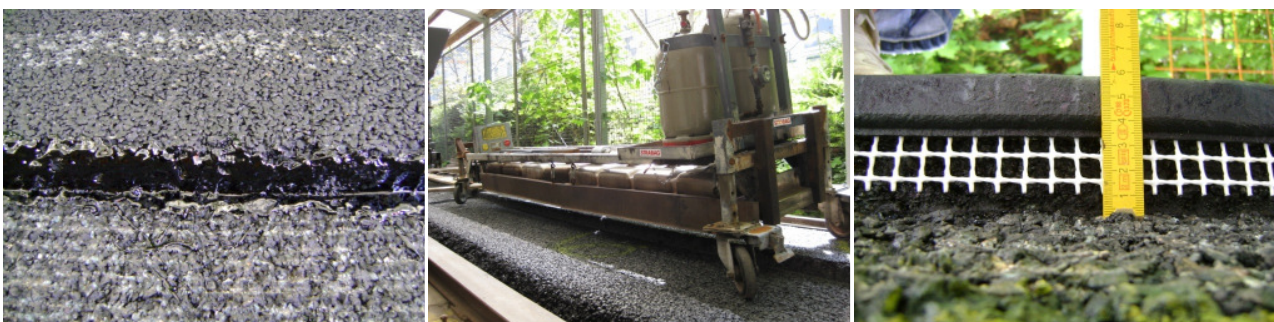
c) Bitumenfugenband für OPA, besteht aus einem selbstklebenden PmB-Band und einem PP-Gitterband.
