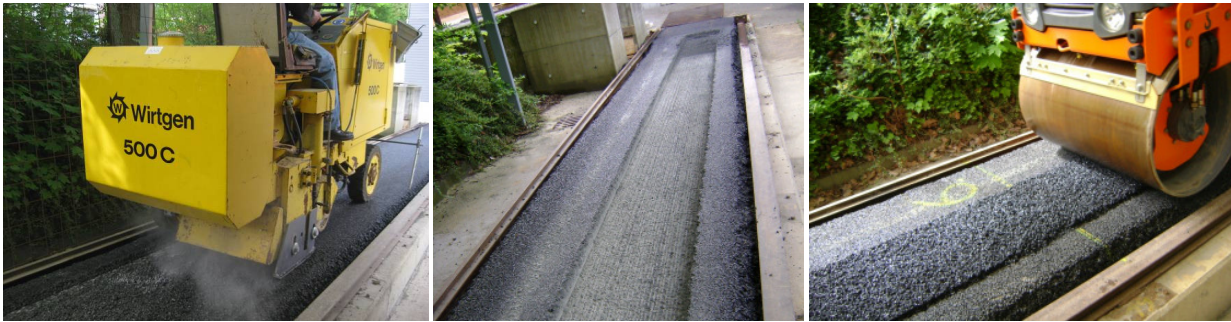
Bild 1: Nahtherstellung durch Fräsen des Asphaltes mittels einer Asphaltfräse in der Versuchsreihe 1
