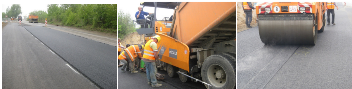
Bild 9: Herstellung der Nahtflanke (links), Erwärmung der Nahtflanke mit Infrarotstrahler (mitte) und Verdichtung mit der Walze in den Außenbahnen (rechts)
