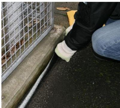
El perfil para el sellado de juntas se coloca en cuanto se haya secado la imprimación previa.
