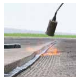
Activer le TOK ® -Band A en quelques secondes à la flamme
