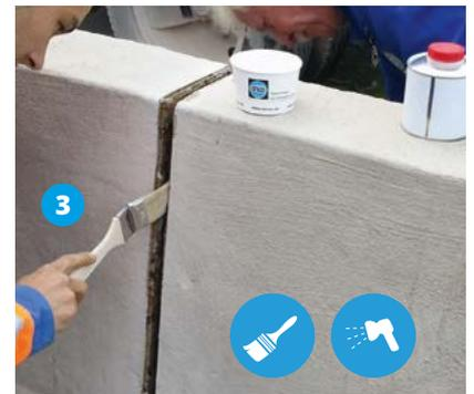
Auftragen des **TOK®-BSW Primer**, entweder mit dem Pinsel oder mit einer Sprühflasche.
