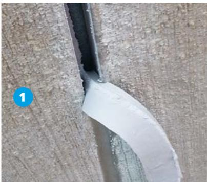
Einfaches Entfernen der vorhandenen Fugenfüllung durch seitliches Einschneiden und Herausziehen.
