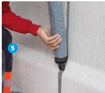
Abdecken der Fugenfüllung mit der Schutzmasse **TOK®-BSW Protect**, die einen dauerhaften Schutz gewährleistet.
