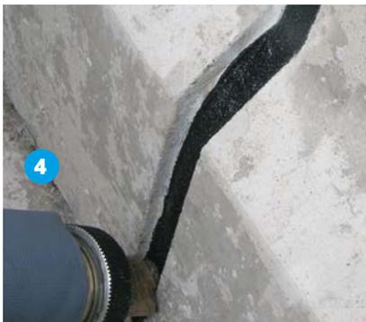
Einfaches Verfüllen der Fuge mit der Fugenmasse **TOK®-BSW Mastic** (geprüft gemäß DIN EN 14 188 - 1).
