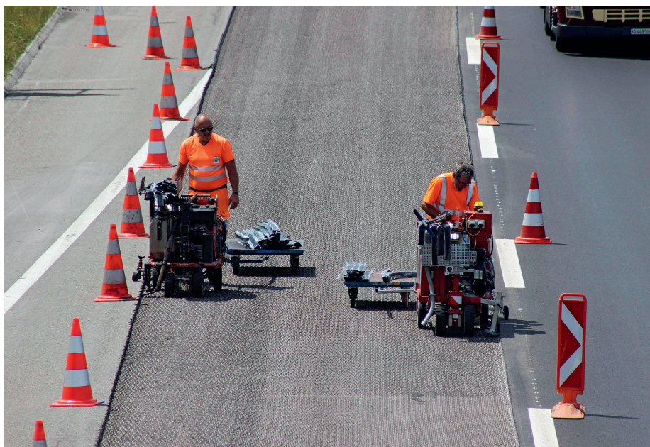
Ausbildung von Fugen mit dem TOKOMAT®
