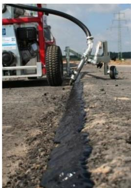
Nähte in Deckschichten entstehen durch den bahnenweisen Einbau von Asphaltmischgut mit vergleichbaren Eigenschaften.
