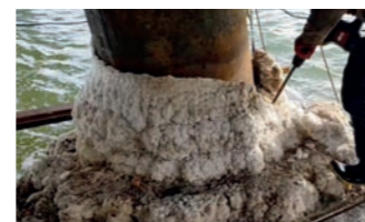
Depósitos agresivos de sal
