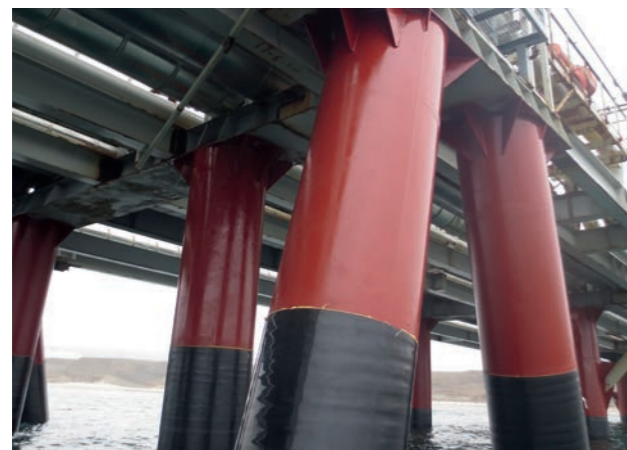
Rusia, Mar Negro, puerto marítimo de Taman MarineProtect®-2000 FD 500 pilotes, DN 1220 (48")
