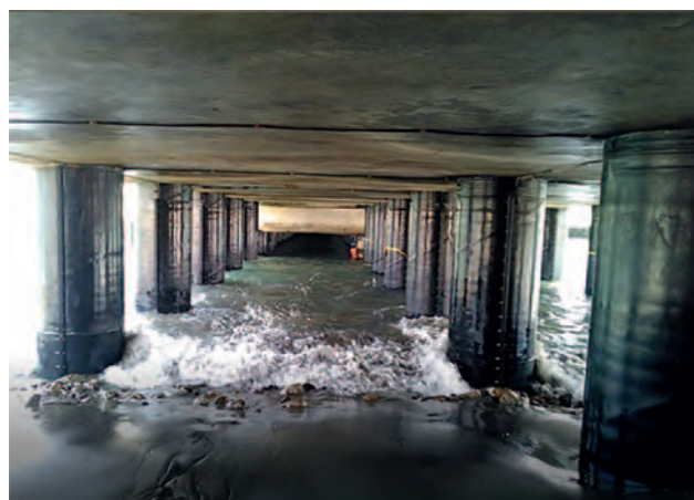
Pérou, port de Talara MarineProtect®-2000 FD 206 piliers, DN 1000 (40")
