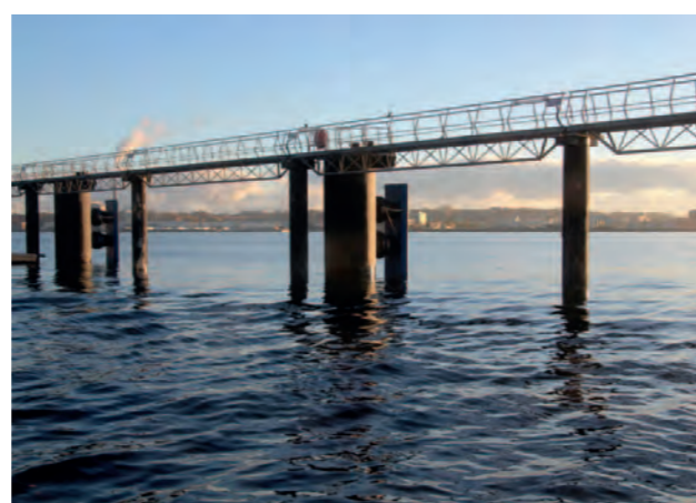
Allemagne, port de Kiel, quai vers la mer Baltique MarineProtect®-2000 FD protection des piliers sur le plus grand quai pour l'accostage des paquebots de croisière, DN 2400 (96")
