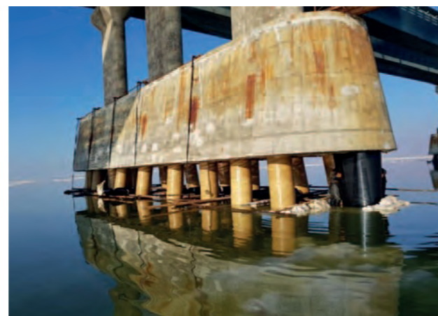
Iran, pont dans le lac d'Ourmia MarineProtect®-100 372 piliers, DN 800 (32")
