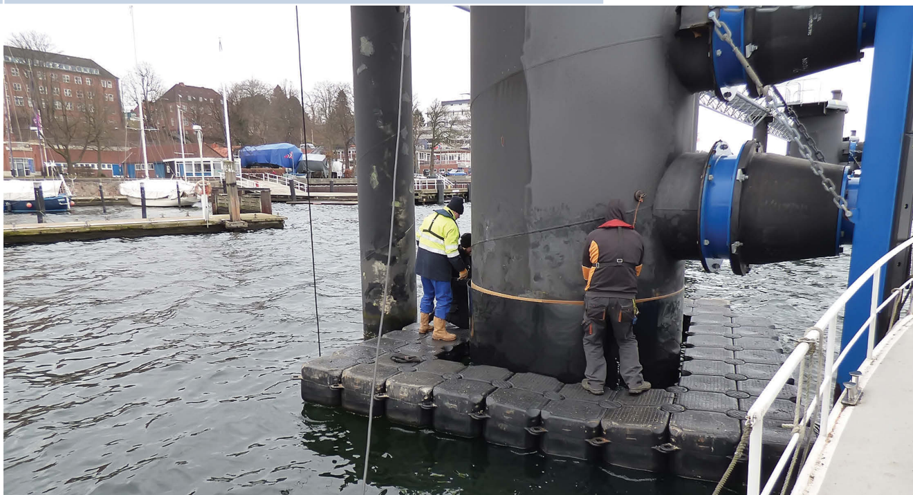
ПРИМЕНЕНИЕ СИСТЕМЫ MARINE PROTECT™ В БАЛТИЙСКОМ ПОРТУ КИЛЬ, ГЕРМАНИЯ
