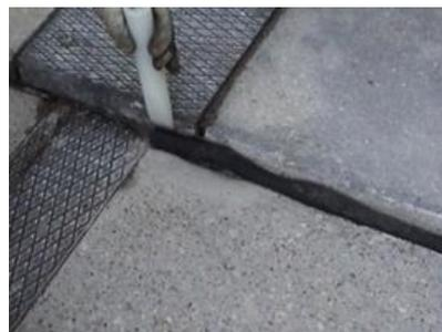
L'étanchéification à l'aide des profilés **FERMADUR®-C** ne doit être réalisée que par des professionnels formés et expérimentés. La mise en œuvre sera généralement effectuée par des entreprises conventionnées dont le personnel a été formé par DENSO France.
