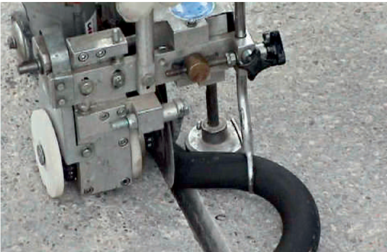
Abbildung 2: Maschinelles Einbauen des Kompressionsdichtprofils
