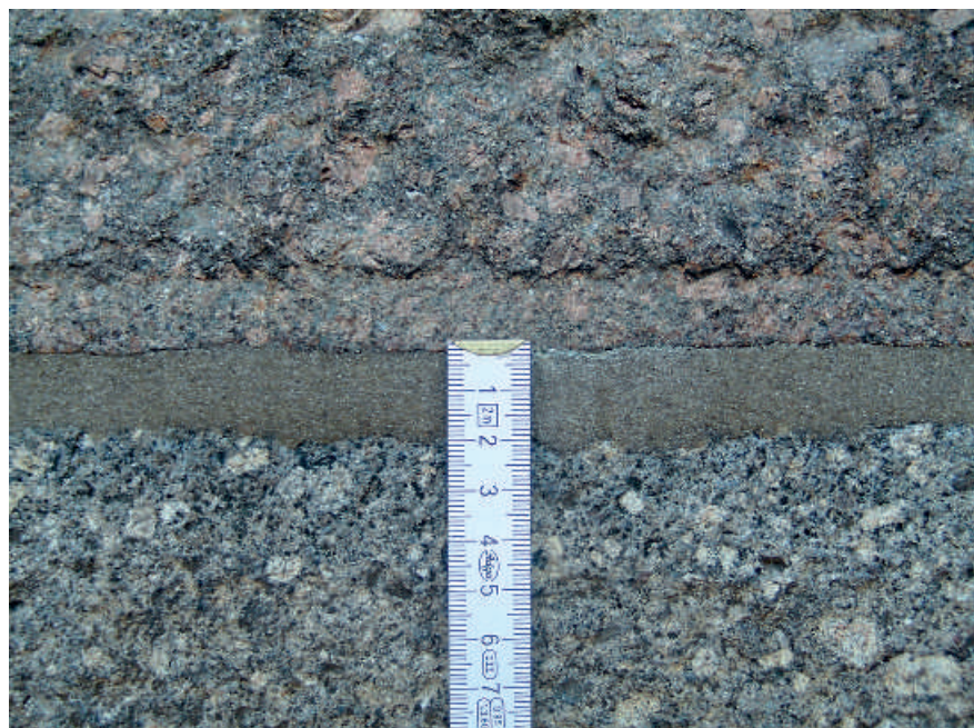
Abbildung 6: Epoxidharzfüllung der sanierten Fuge. Dahinter liegt als Fugenabdichtung das Kompressionsdichtprofil
