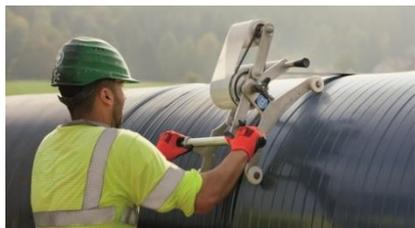
**DENSOMAT®-KGR Junior** permet la mise en œuvre de rouleaux de grande longueur. **DENSOMAT®-KGR Junior** est particulièrement adaptée pour les applications sur des diamètres importants. Les accessoires supplémentaires disponibles permettent une mise en œuvre sur des DN 2000 ou supérieurs.
