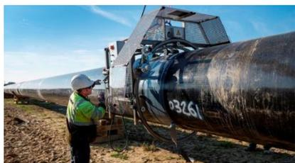
Le **DENSOMAT®-11** est une machine d'enrobage semi-automatique motorisée (moteur essence). **DENSOMAT®-11** est idéale pour les réhabilitations de canalisations ou l'enrobage de joint de soudure dans le cadre de travaux neufs. Deux bandes peuvent être appliquées simultanément, permettant ainsi d'appliquer en une seule fois un système de bandes multicouche.
