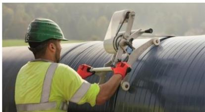
**DENSOMAT®-KGR Junior** позволяет наносить ленту в рулонах большей длины. **DENSOMAT®-KGR Junior** превосходно выполняет требования при работе с большими диаметрами. Комплект вспомогательного оборудования позволяет выполнять обмотку труб диаметром от DN 2000 и более.
