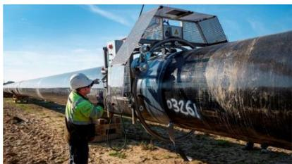
**DENSOMAT®-11** – это мобильное автоматическое намоточное устройство с бензиновым двигателем. **DENSOMAT®-11** идеально подходит для восстановления участков трубопровода и для изоляции сварных стыков при прокладке новых трубопроводов. Одновременное использование двух рулонов лент позволяет наносить многослойную ленточную систему в один прием.
