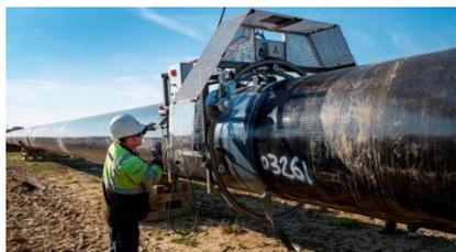
**DENSOMAT®-11** es una encintadora móvil automática accionada mediante un motor de gasolina. **DENSOMAT®-11** es ideal para rehabilitaciones de secciones de tuberías y, en obras nuevas, para el revestimiento de uniones de soldadura. Los dos alojamientos de bobina permiten la aplicación de un sistema de cinta de varias capas de una vez.
