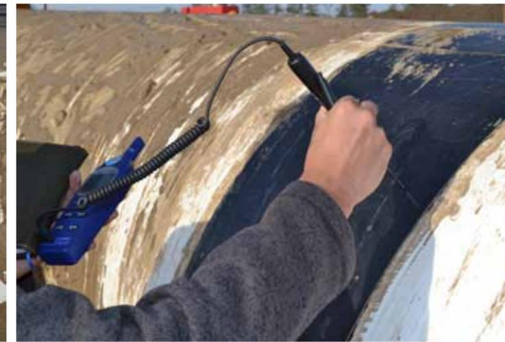
На первом этапе с обеих сторон на заводское покрытие была намотана пластиковая лента DENSOLEN. Однако в нашем случае её функция сводилась не к обеспечению минимальной толщины покрытия над сварным стыком в качестве «распорки» (толщина заводского покрытия практически втрое превышает минимально допустимое значение 2,5 мм). Скорее, лента DENSOLEN понадобилась в качестве своего рода фиксатора – ограничителя общей конструкции кожуха.
