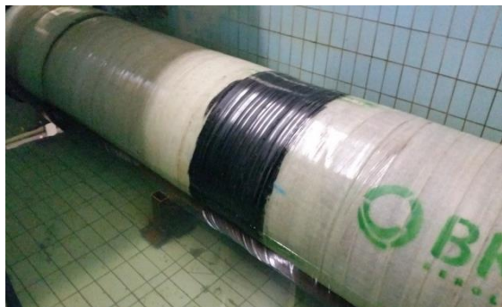
Плавающая прокладка труб в воде
