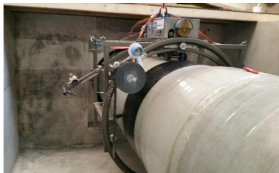
Машинное нанесение DENSOLEN®-AS50
