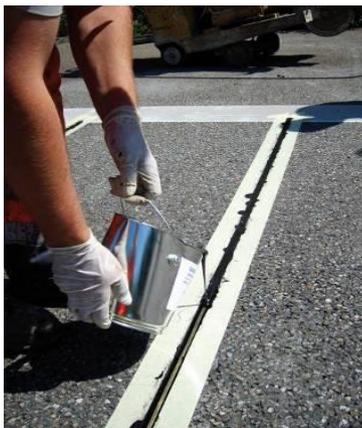
Die Oberflächentemperatur der Schlitzflanken muss mindestens +5 °C (+41° F) betragen, max. +40 °C (+104 °F). Der Taupunkt muss unbedingt beachtet werden. Eventuell aufsteigende Luftblasen müssen entfernt werden (z.B. durch Überstreichen mit einem Pinsel, oder durch kurzes Anflämmen mit einem Gasbrenner) bevor
