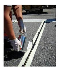
Температура поверхности граней паза должна быть не ниже+ 5 °C (+41 °F) и не выше +40 °C (+104 °F). Обязательно учитывать точку росы. Образовавшиеся пузырьки воздуха следует удалить (например, пройдя сверху кистью или
