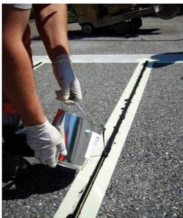
La temperatura de la superficie de la junta tiene que ser de al menos +5 °C (+41° F), máx. +40 °C (+104 °F).
