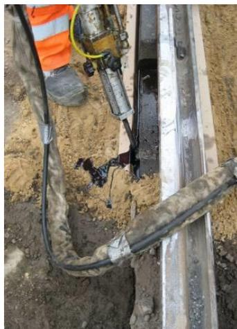
Die qualitativ beste und schnellste Verarbeitung erfolgt maschinell mit einem 2-Komponenten Dosiergerät.
