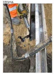
Приставший к стенкам материал нужно также смешать с остальным содержанием. Самое качественное и быстрое нанесение обеспечивается с помощью двухкомпонентного дозирующего устройства. Температура воздуха и основания должна составлять от +5 °C (+32 °F) до +35 °C (+95 °F).
